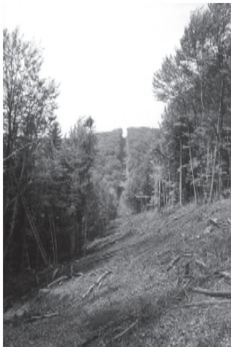
Ryc. 2. Las wycięty w związku z budową kolei gondolowej ( fol. M. Styczyński )
