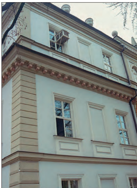
Fot. 2. Narożnik budynku dawnego Obserwatorium Astronomicznego UJ od strony północnej. Widoczna klatka z termometrami przymocowana do okna na II piętrze (obecnie Collegium Śniadeckiego).
