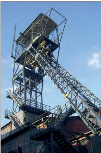
Fot. 3. Wieża szybu „Carnall” w Skansenie Górnicyz „Królowa Luiza” w Zabrzu (fot. J. Koj)
