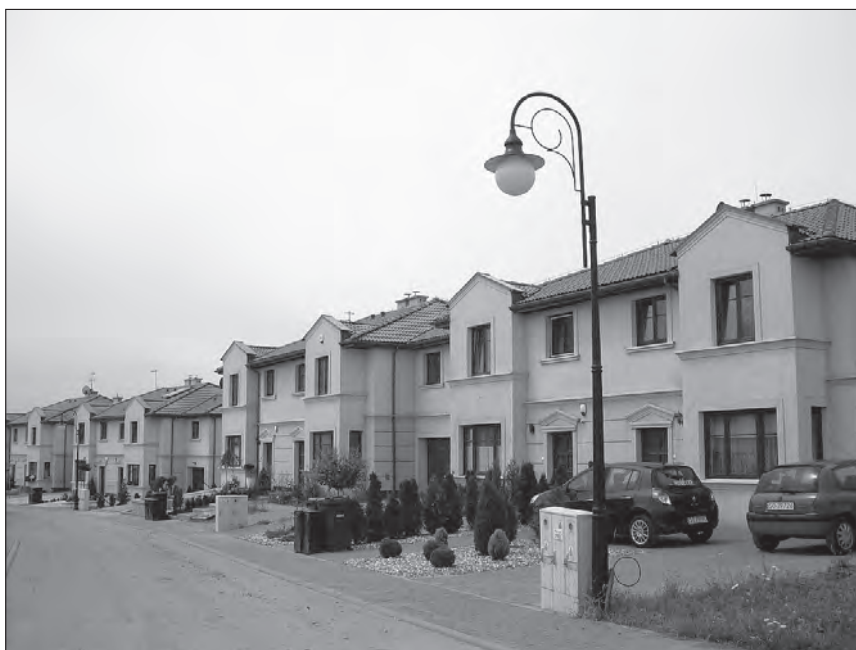
Fot. 3. Osiedle „Słoneczne Domy” (fot. T. Spórna, W. Dragan)
