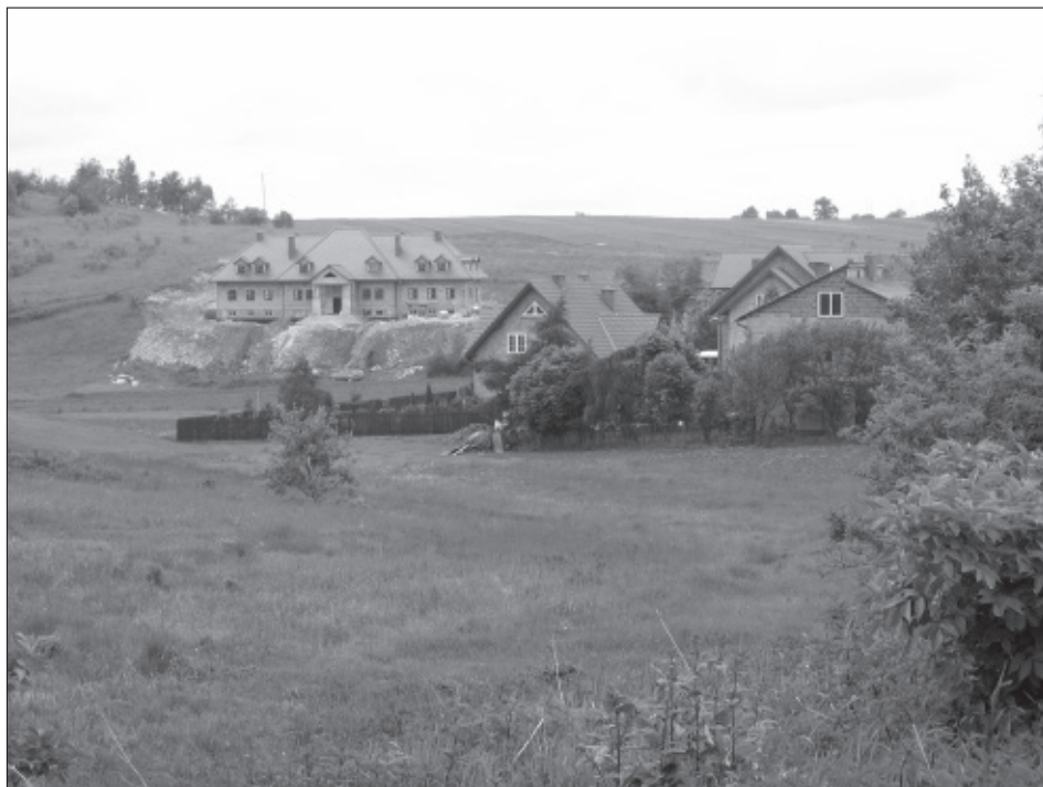
Ryc. 2. Przykład nowej zabudowy (hotelu) docierającej do granic Parku w rejonie Woli Kalinowskiej, (fot. J. Partyka)
